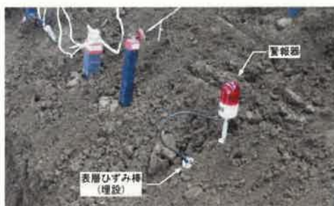
埋設時の状況
